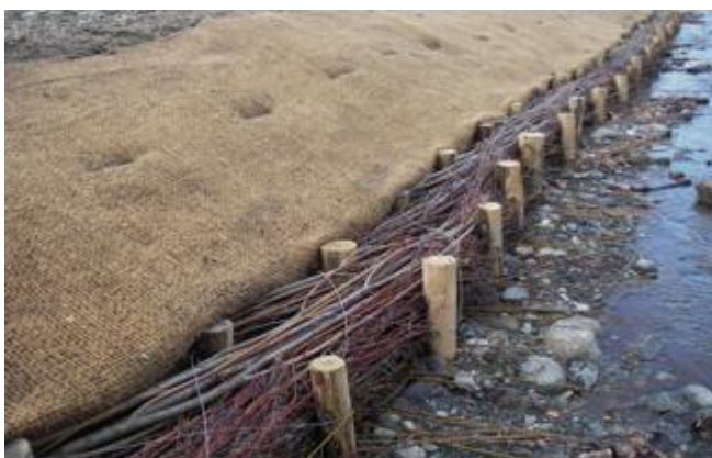
Figure 10 Illustration et principe d'implantation des fascines (Sources : Genibiodiv.inrae.fr (gauche)/ Les fascines de ligneux en génie végétal, INRAE, OFB, 2023(droite))
