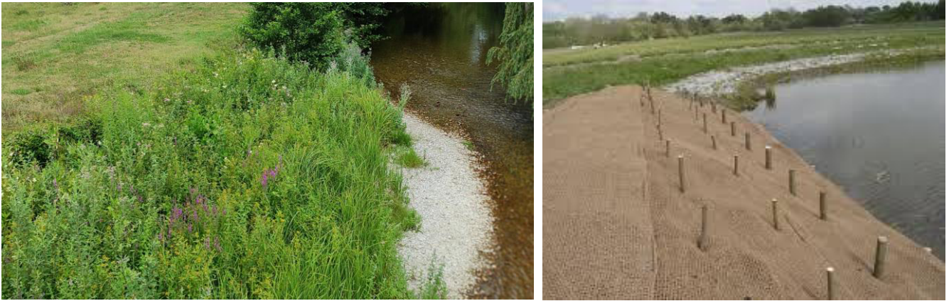
Photo 7 Illustration des plantations d'hélophytes (gauche) et bouturage (droite)
