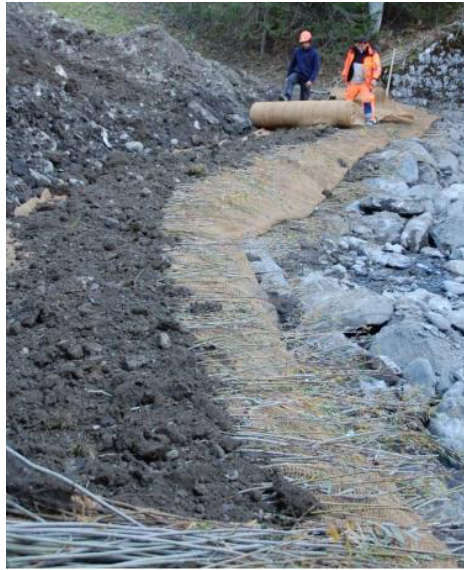
Photo 5 - Aménagement d'un lit de plants et plançons (source – Journée technique, Techniques de génie végétal applicable en rivière de montagne, Frossard)
