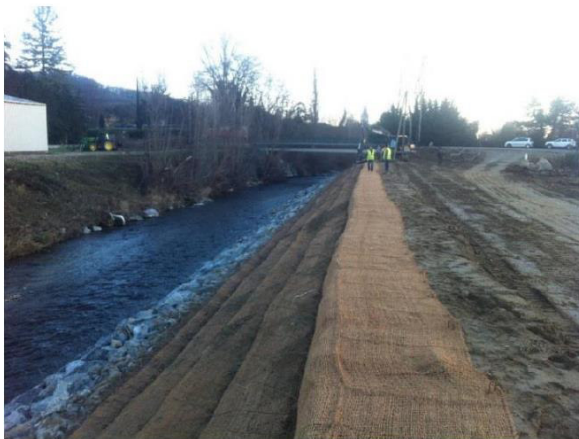
Photo 6 – Aménagement d'une protection de berges en technique mixte avec des lits de plants et plançons (Source - SAGE Environnement)
