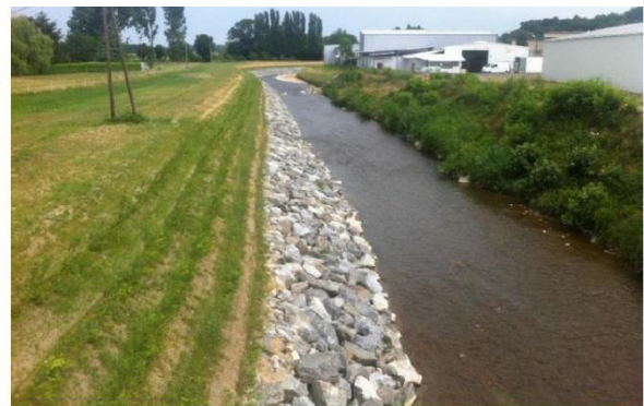
Photo 6 – Aménagement d'une protection de berges en technique mixte avec des lits de plants et plançons (Source - SAGE Environnement)
