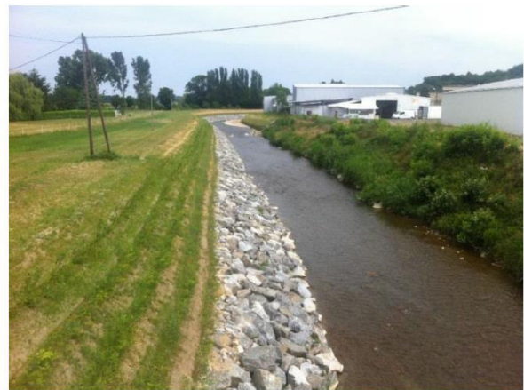
Photo 6 – Aménagement d'une protection de berges en technique mixte avec des lits de plants et plançons (Source - SAGE Environnement)
