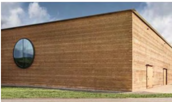
Usine Ricola mur en pisé Ertzog&Demeuron fendu, GLV
