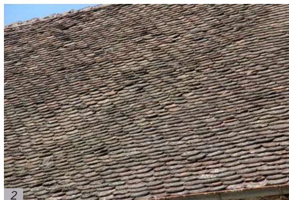
4 : Toiture en tuile plate arrondies, Rue de la Cascade, Brégnier-Cordon (01). © SP/CAUE de l'Ain.
