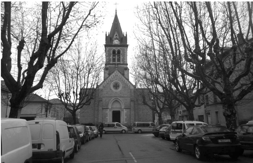
Champagne-au-Mont-d-Or (69) - Avant travaux - Ateliersite - Source : A-lautier
