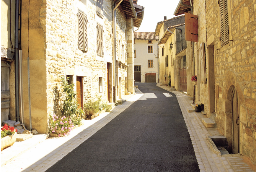
Val-Revermont – Après travaux – Source : CAUE 01
