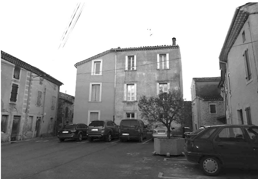
Assignan (34) – Avant travaux - Source: Ateliersites
