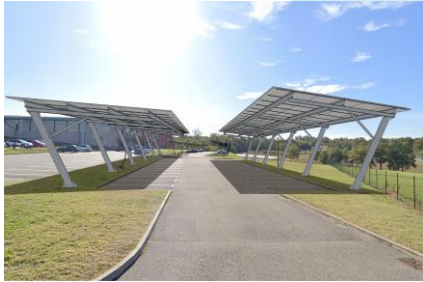
CCVSC – 0,8 M€ – Travaux en 2024
