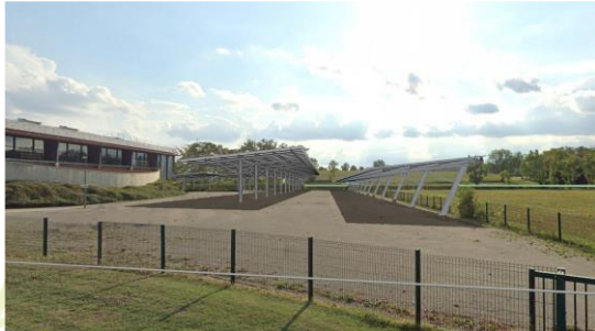
CCVSC – 0,9 M€ – Travaux en 2024
