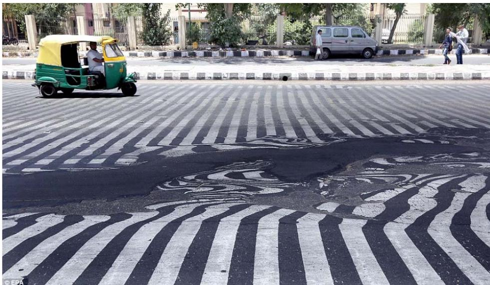
Déformations suite à la fonte partielle de la chaussée en Inde à Dehli en 2015. Source : The Guardian.
